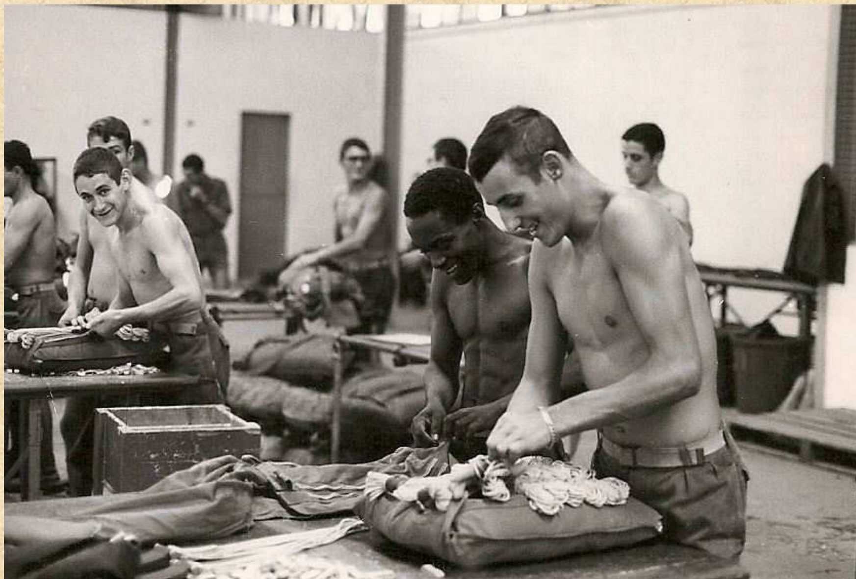
Le lovage des suspentes sur le sac à voile
