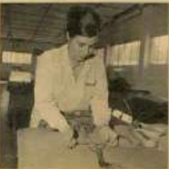
Le lavage des parachutes. Un crochet suspendu sur un rail fixé au plafond permet ensuite de drainer, sans effort, le parachute vers la salle de séchage.
