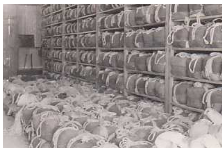
Stockage des G1 2 à Hanoi
